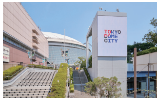
プリズムホール塔体ビジョン
