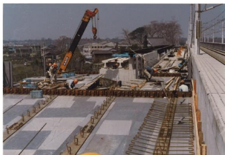
小針駅（仮称・現内宿駅）建設風景
