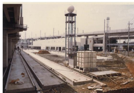
留置線建設風景
