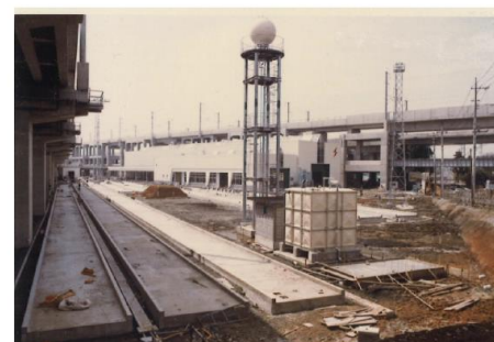
留置線建設風景
