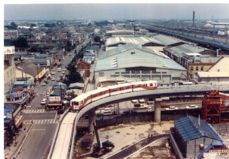
大宮駅を発車してループ線を走行する （JACKビル建設中）
