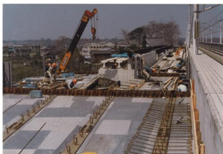
小針駅（仮称・現内宿駅）建設風景
